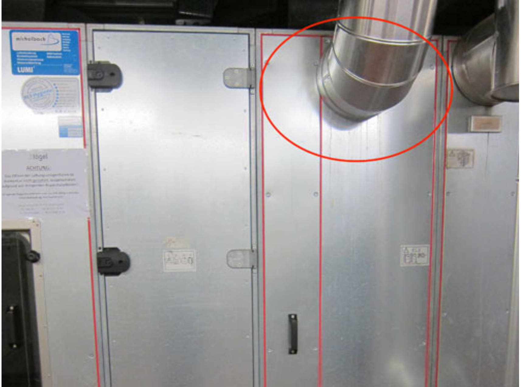
Keine Zugänglichkeit zu dem Tropfenabscheider Reinluftseitig.
